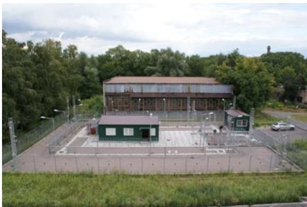
Навчально-тренувальний майданчик «Комплекс інженерно-технічних засобів системи фізичного захисту»
