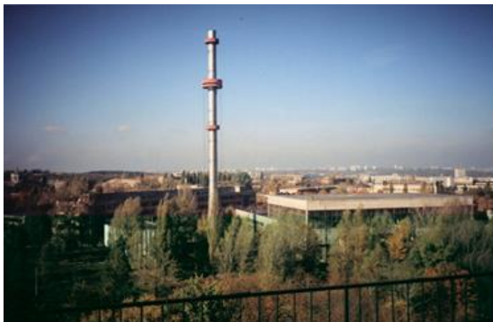
Будівля циклотрона У-240
